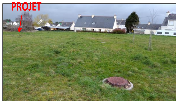
5. Vue depuis le Sud du projet vers le Nord (Bassin de rétention du lotissement Glazen)
