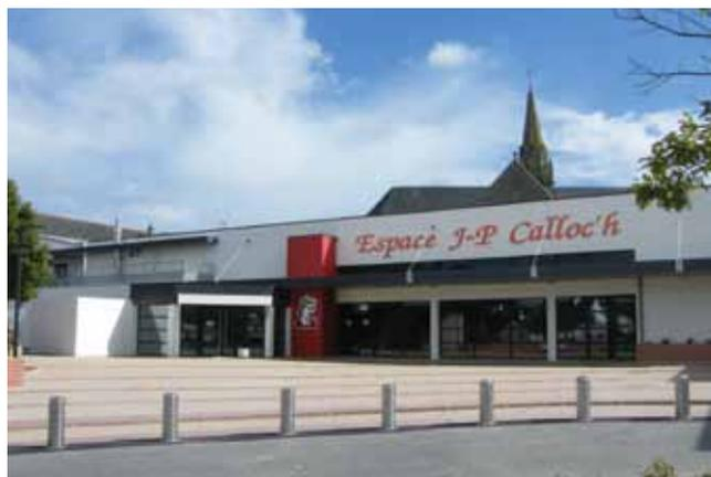
Après plusieurs mois de travaux, l'arrière de l'espace J-P Calloc'h a été réaménagé. L'entreprise Eurovia, sous la maîtrise d'oeuvre du Cabinet Servicad en charge des travaux de l'esplanade, a remplacé les dalles alvéolées par du béton désactivé. Ce nouveau parterre facilite les livraisons et accueillera si besoin des manifestations en plein air.
